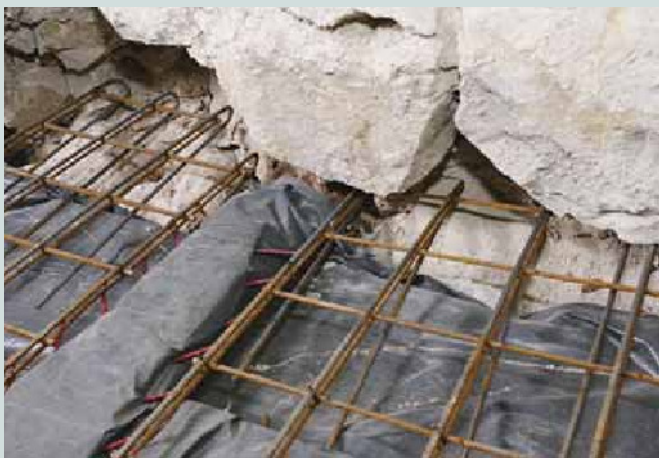
Holz-Beton-Verbunddecke. Die Schubverbindung wird über die eingedrehten Dollen hergestellt, gleichzeitig füllt der Beton jede Aussparung des Mauerwerks und ummantelt die maroden Balkenköpfe.
